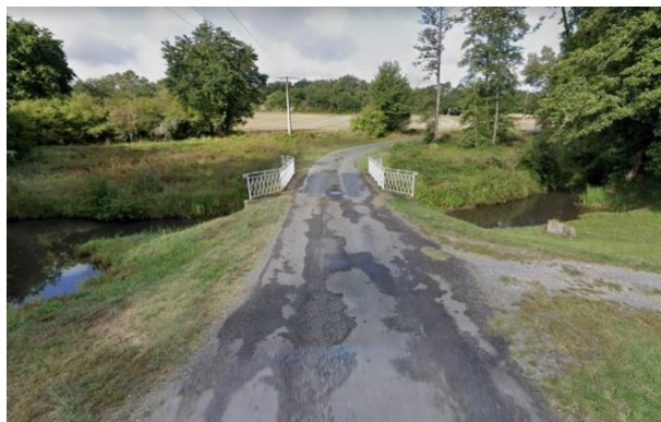
Figure 8 : Passage au-dessus du ruisseau de la Nauve de la Motte (Source : Google 2019)
