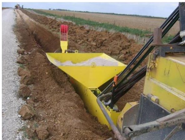
Figure 9 : Exemple de trancheuse et dépose du câble
